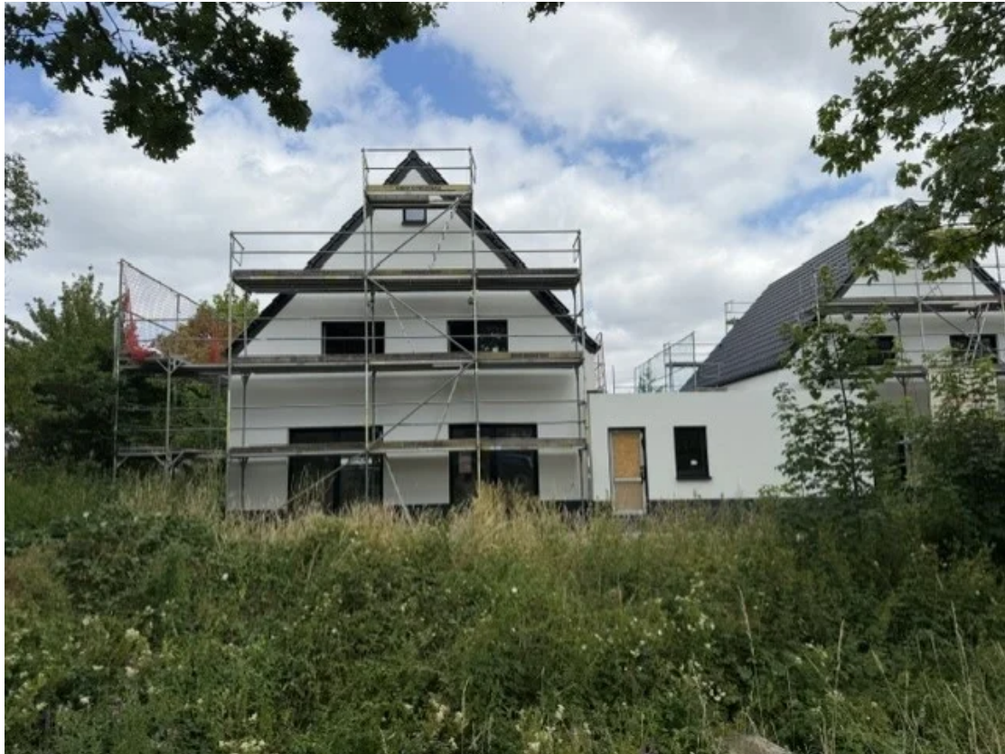
Aktuell im Bau
