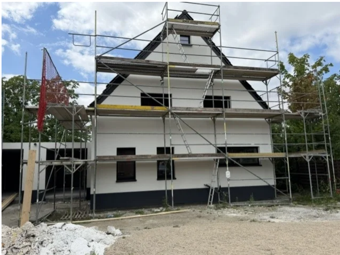
Aktuell im Bau
