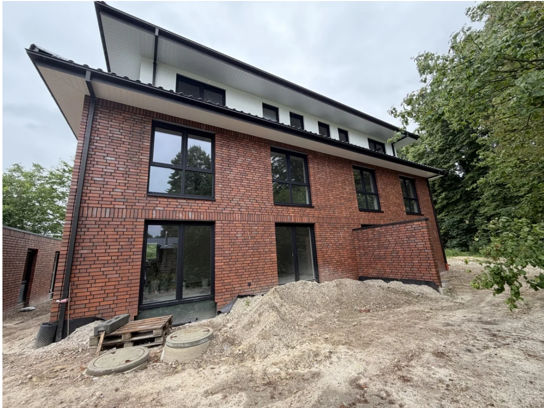
Aktuell im Bau
