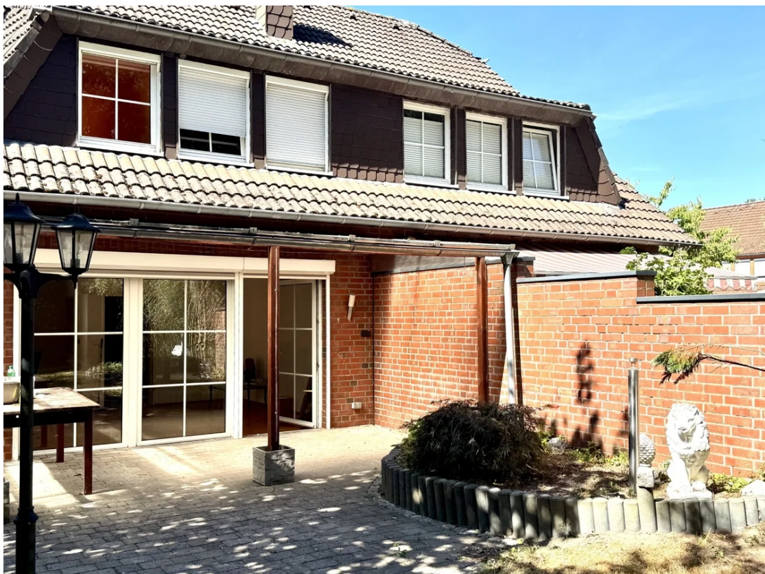
Terrasse mit Überdachung
