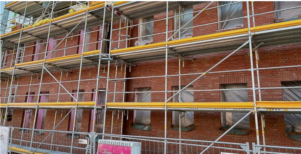
Die Klinkerfassade am historischen Rathaus in Nordkirchen ist fast fertiggestellt.
