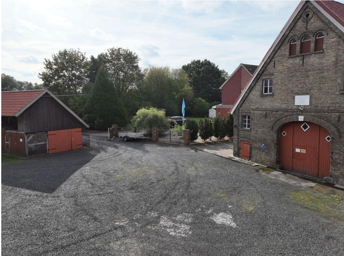
Scheune mit Remisse
